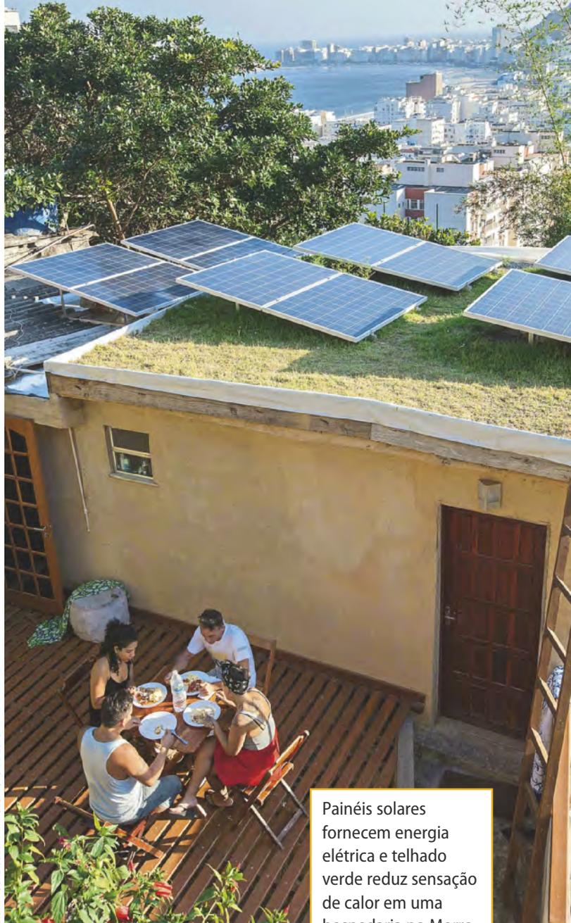
Painéis solares fornecem energia elétrica e telhado verde reduz sensação de calor em uma hospedaria no Morro da Babilônia, no Rio de Janeiro (RJ).
