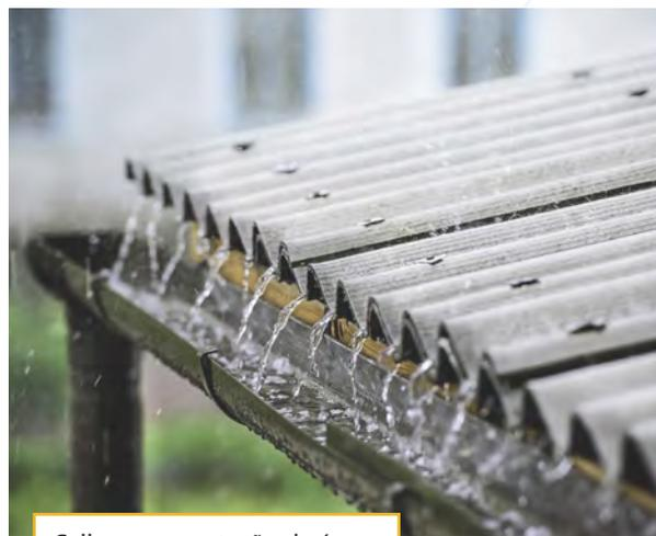
Calha para captação da água da chuva.
